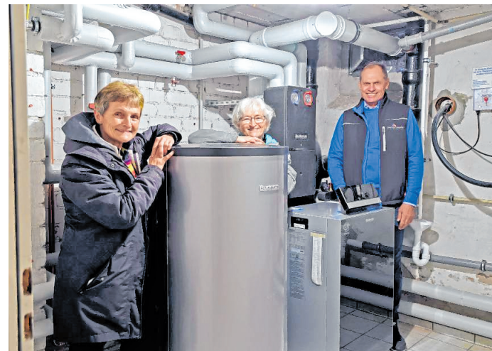
Joachim Mainka zusammen mit Rosemarie Schmid und Elisabeth Weingärtner vor der Außen- und Inneninstallation der Luft-/Wasserwärmepumpen-Anlage mit Gas-Brennwerkessel.
